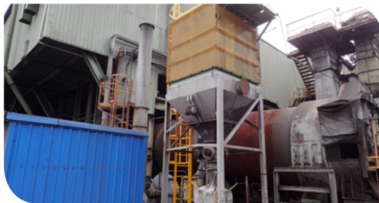
1J 冷卻窯集塵機整修工程
